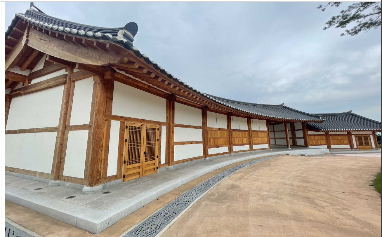
한국문화테마파크 판매시설-1 현장 사진 1
